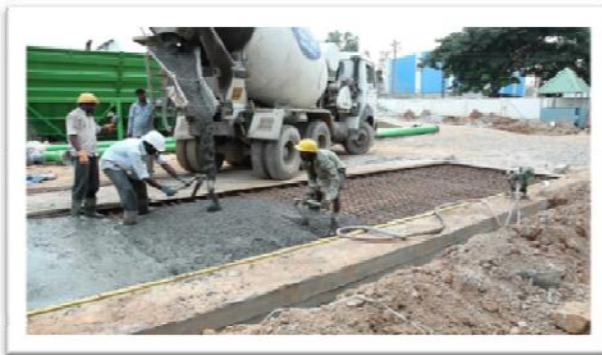
5. Concrete Pouring & Leveling
